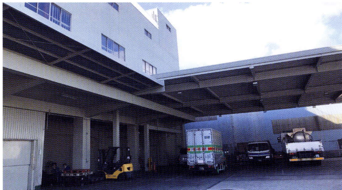
▲大阪府堺市堺区の同社本社屋
